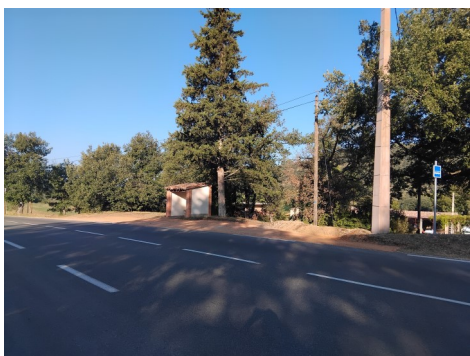
Création arrêt de bus « Maison de Pays »
